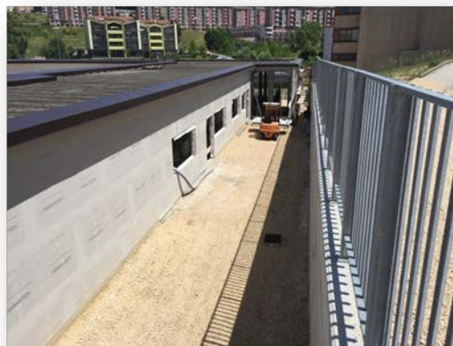
Figura 6 – Le aule del piano rialzato lato sud-ovest
