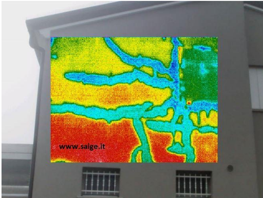
indagine termografica su cappotto termico
